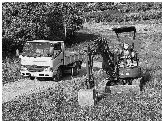
ダンプ・バックホウでの基盤整備
